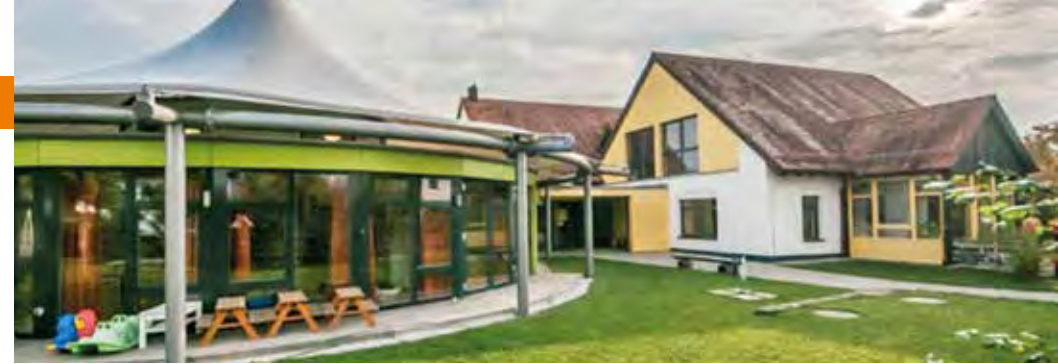
Das undichte Flachdach unter dem Zelt wird endlich saniert
